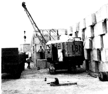
Stapeling van uit Brabant aangevoerde blokken op het plateau van Voorne
