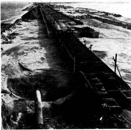
Het sluitgat van de Lauwerszeedijk gezien van de Friese kant. Op de voorgrond de loopbrug die zorgt voor verbinding met de vaste wal
