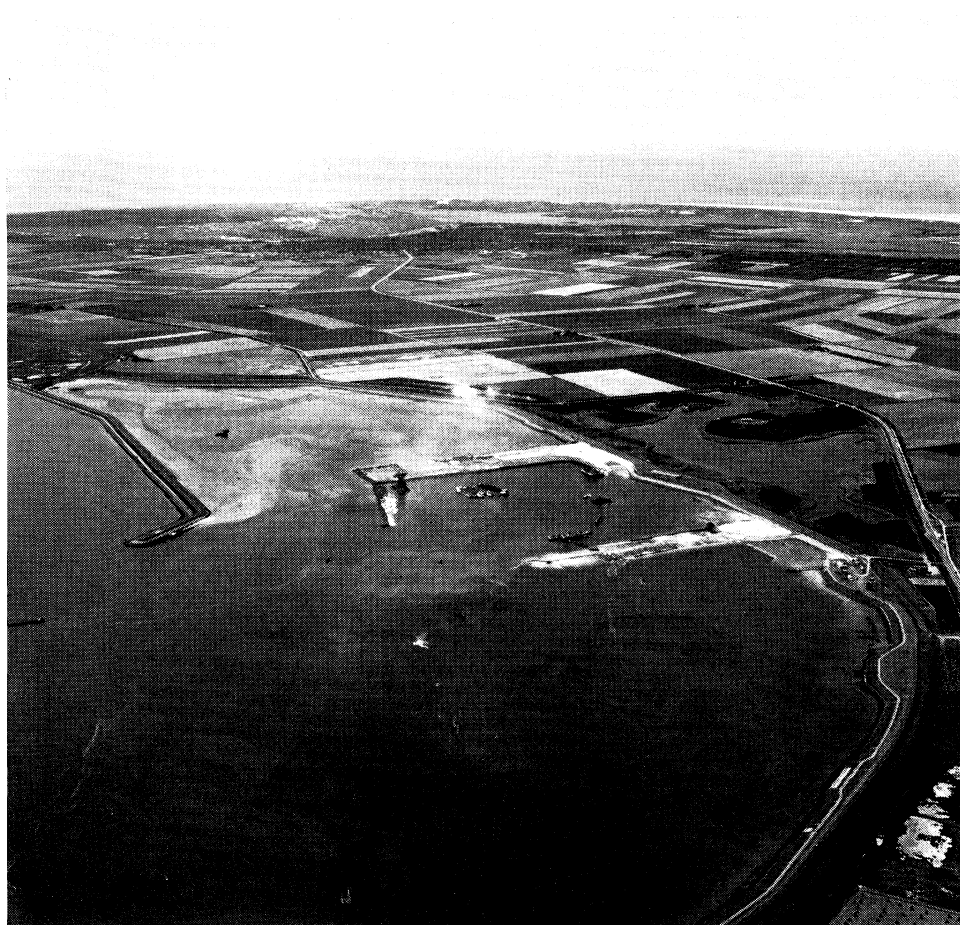
De werkhaven 'Schelphoek' op Schouwen in aanleg. Foto van 31-7-'67
