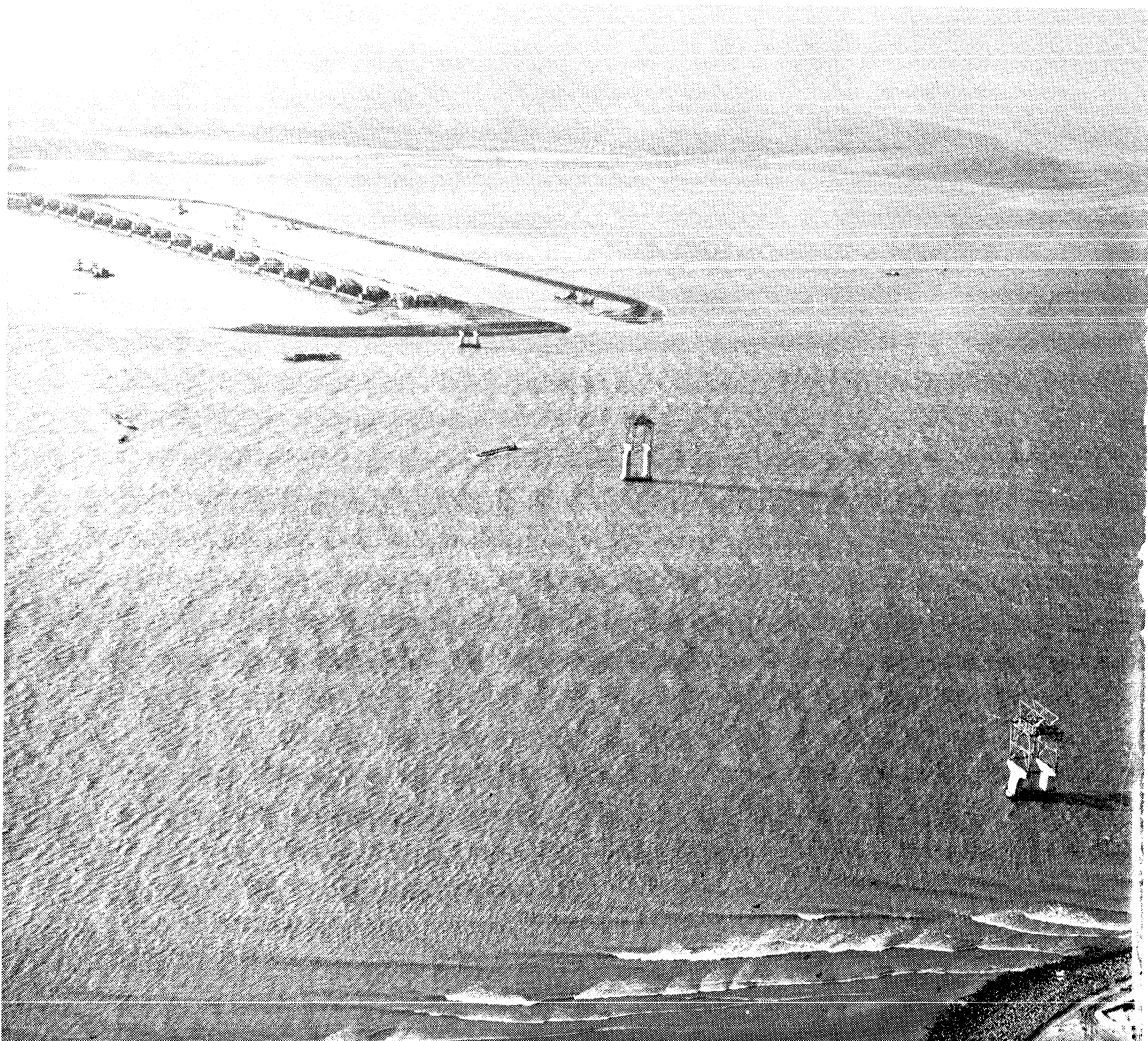
Het opruimen van de ringdijk. Op de voorgrond de kabelbaan in aanleg. Foto d.d. december 1967
