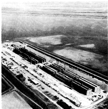
De bouwput van de doorlaatcaissons voor de afsluiting van het Brouwershavensche Gat. Opname op 30 september 1969
