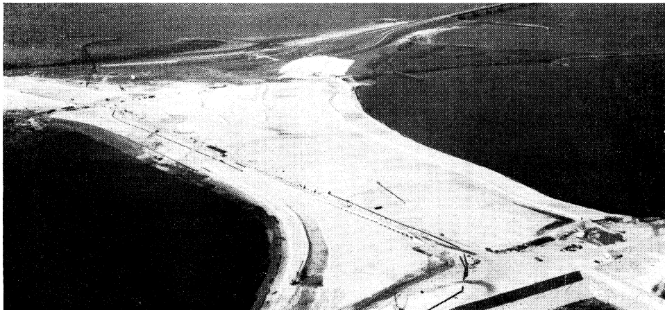
Zandlichaam van de dam door het Volkerak. Stand van het werk op 19 september 1969
