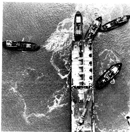
Plaatsing van een enkele caisson De lier trekt aan. De kruisdraden zijn al aangebracht
