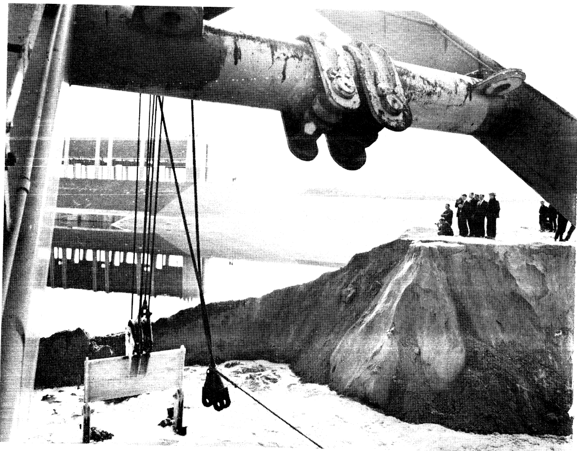
Doorbaggering van de ringdijk van de bouwput voor de uitwateringssluizen; voorjaar 1968
