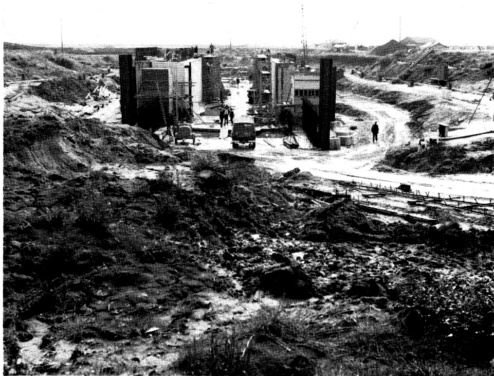
De sluisbouw in Dokkumer Nieuwe Zijlen in volle gang
