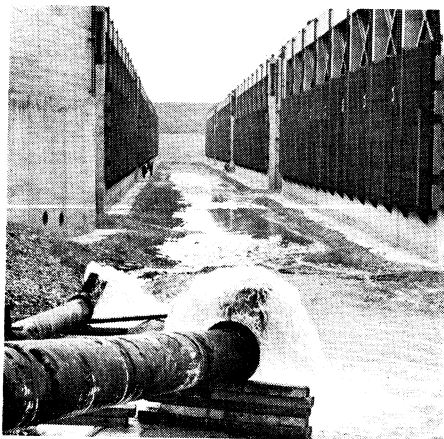
De bouwput van de caissons voor het Volkerak loopt vol, 14 juni 1968
