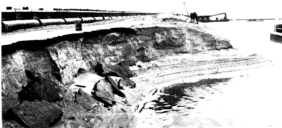
Afkalving van het binnentalud
